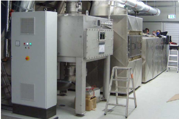
Molekularsiebgestützte NT-Plasmaanlage für 10.000 m 3 /h Abluft aus Herstellungsprozessen von Aromastoffen
